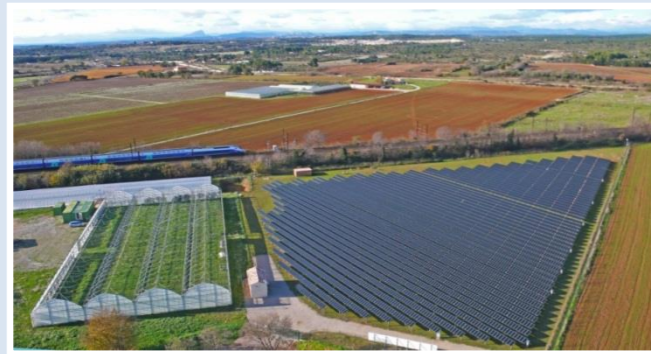
Centrale Solaire de LUNEL Département : Hérault (34) Puissance électrique : 500 KWc Mise en service : Septembre 2008
